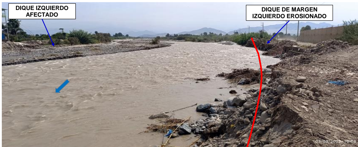
FIGURA N°04: RIO CHANCAY HUARAL, CON LA MARGEN IZQUIERDA AFECTADO POR EROSION , EL CAUCE COLMATADO Y MARGEN DERECHA CON EL DIQUE EROSIONADO POR EL CAUDAL.
