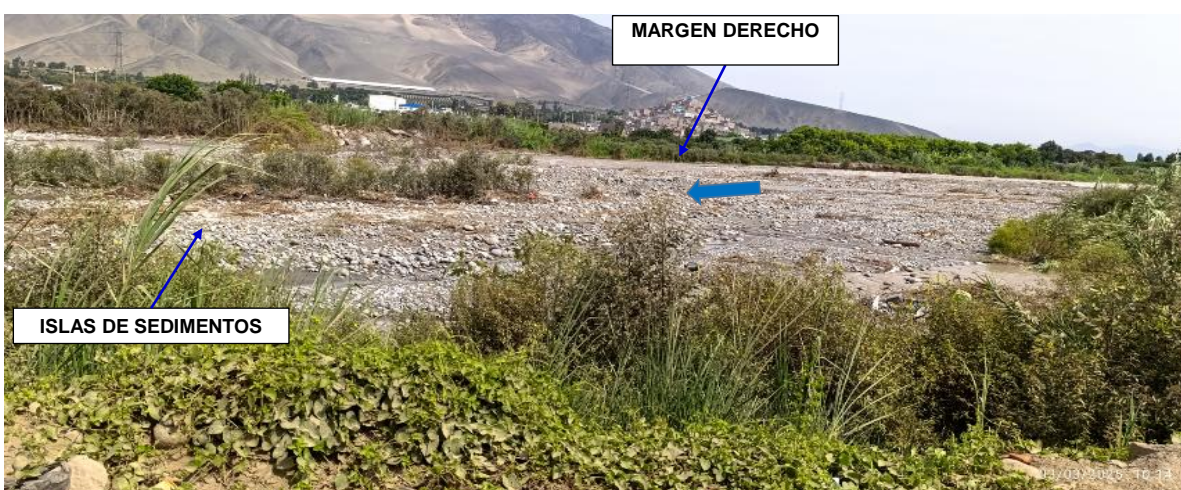
FIGURA N°03: RIO CHANCAY HUARAL, CON EL CAUCE MUY COLMATADO CON ISLAS DE SEDIMENTOS CON VEGETACIÓN Y EL DIQUE AFECTADO EN LA MARGEN DERECHA EN SU MAYOR PARTE, CON ALTO RIESGO A DESBORDE QUE AFECTARIA A AREAS DE CULTIVO Y VIVIENDAS VARIOS.
