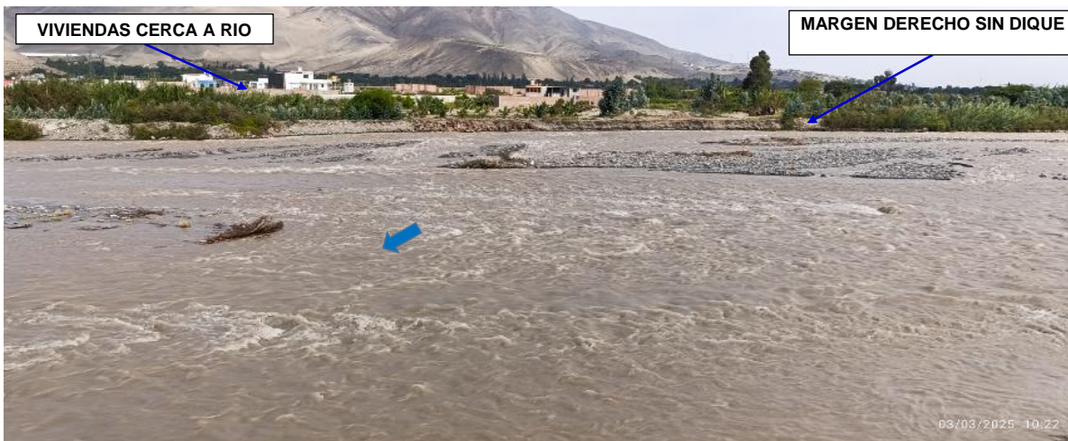
FIGURA N°02: RIO CHANCAY HUARAL CON EL CAUCE COLMATADO CON ISLAS DE SEDIMENTOS, DESVIANDO EL CAUDAL HACIA LOS BORDOS CAUSANDO EROSION EN LOS DIQUES DE ARENA Y MARGEN DERECHA SIN DIQUE.
