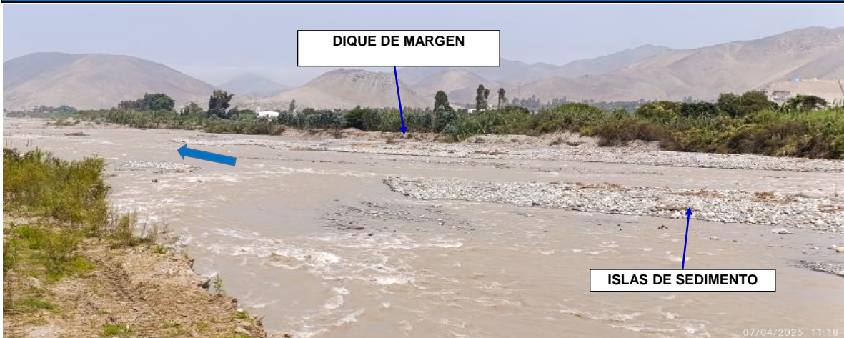
FIGURA N°01: RÍO CHANCAY HUARAL, MARGEN DERECHO SECTOR SANTA ROSA CON EL DIQUE CONFORMADO DE MATERIAL PROPIO EROSIONADO Y EN PARTES NO HAY DIQUE; EL CAUCE DEL RIO SE ENCUENTRA COLMATADO Y SE APRECIA ISLAS DE SEDIMENTOS.
